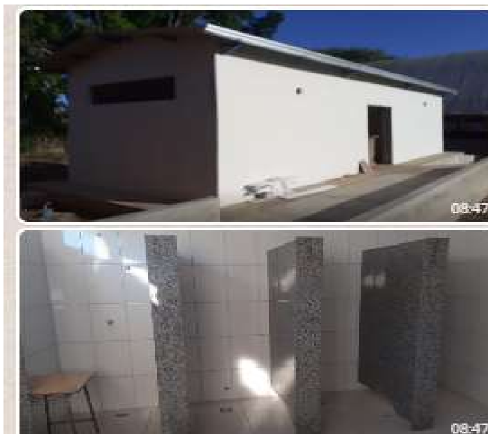
Início da construção de banheiros na EMEIF Prefeito Marcos Donadon.
