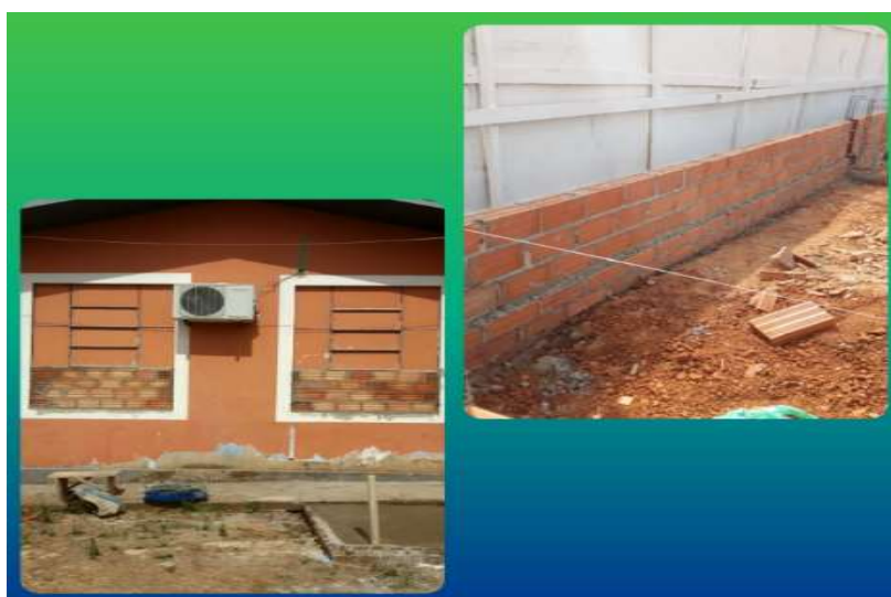
Reformas e pequenos reparos nas unidades de ensino da rede pública municipal
