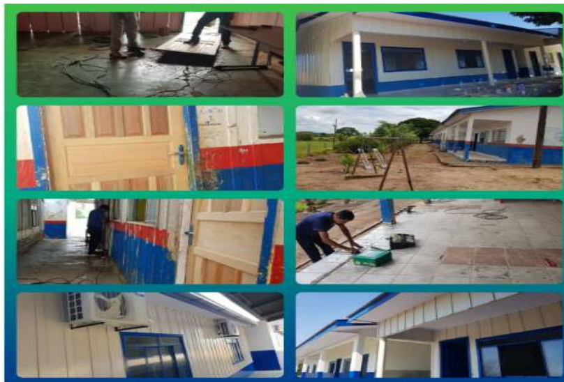
Manutenção e reparos da EMEF Planalto
